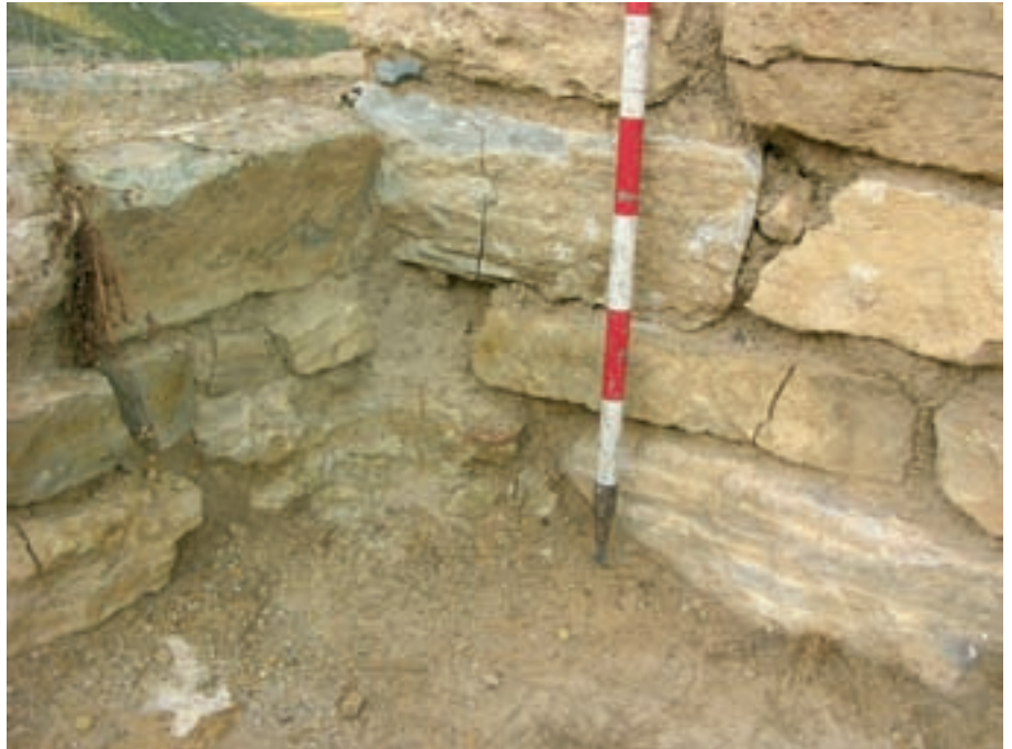
Detalle de una pieza de ángulo entre el muro divisor del torreón C y el paramento interno de la muralla de la Fase 2
