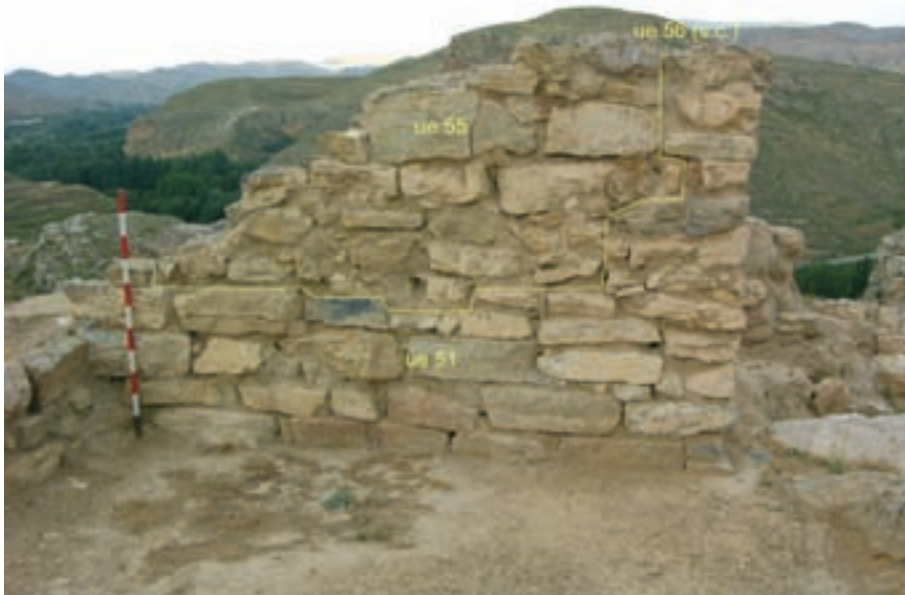
Paño interno del torreón del sector C
