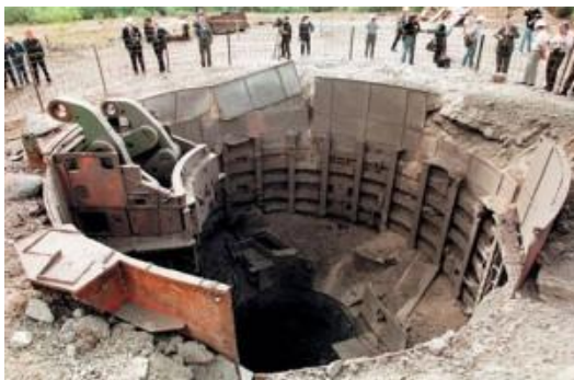
Рис. 5 – Внешний вид хранилища твёрдых радиоактивных отходов объекта «Макаров».
