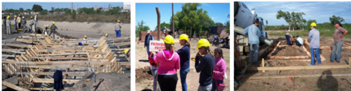
Imagen 9. Cuarta etapa. Ejecución del plan de reasentamiento. Fuente: SUOPE
