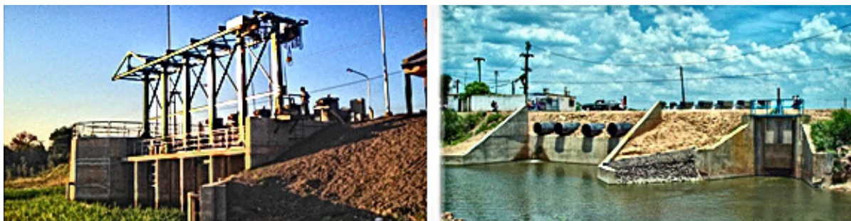
Imagen 11. Obras estructurales. Fuente: SUOPE
