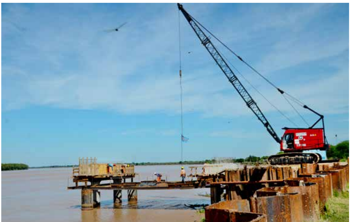
Construcción del muelle puerto Las Palmas
