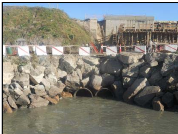
Figura 4. Descarga de la Planta de Tratamiento de Efluentes Cloacales. Fuente: archivo personal. 19/05/2010
