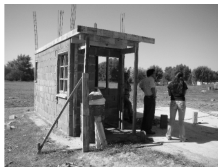
9 y 10- Construcción vía húmeda de la vivienda Fuente: proyecto PID 23121
