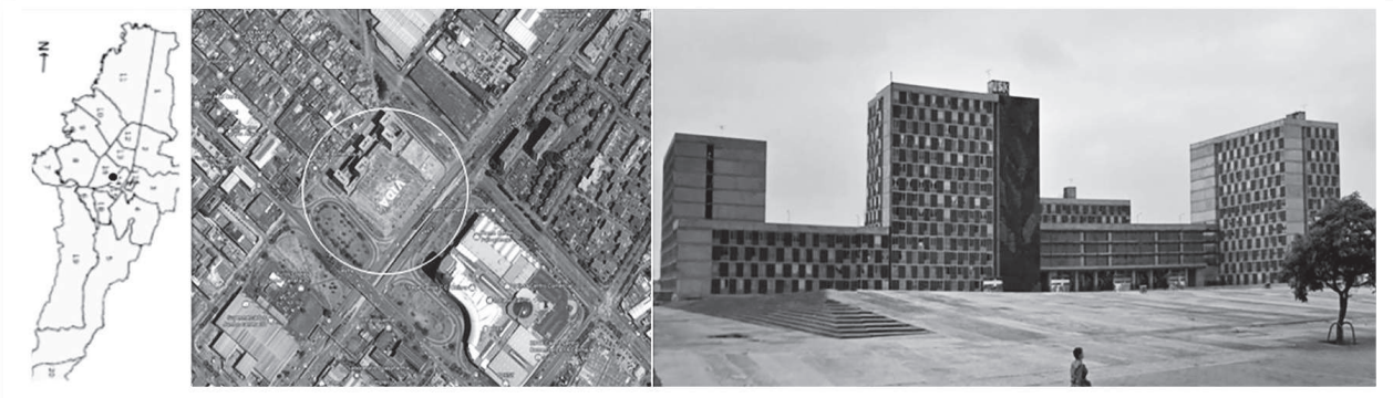
Figura 2. Proyecto de la Hoja en Bogotá. Contexto de localización y fotografía del conjunto.
