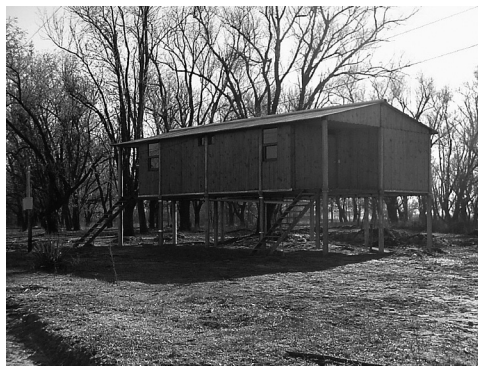
Foto 3. Sistema constructivo UMA Fuente: archivo fotográfico de CEVE
