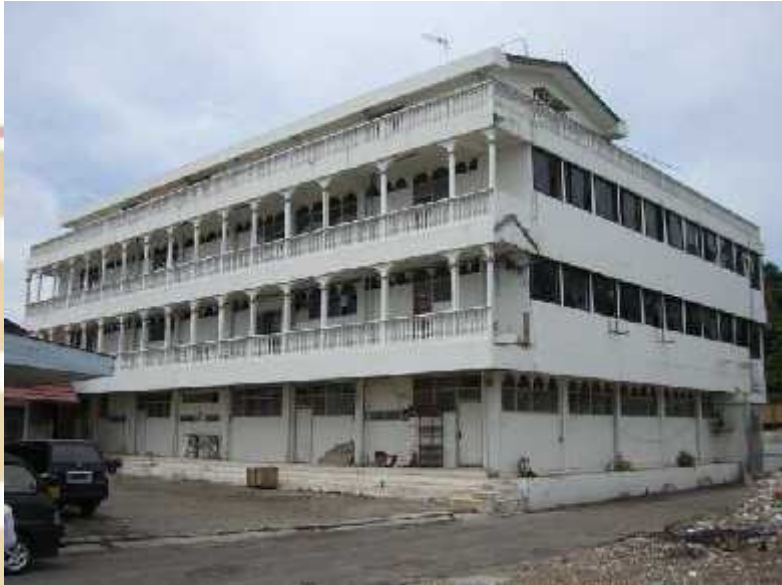
Gambar 1.2 Bangunan yang Bertahan Akibat Gempa Sumatera Barat
