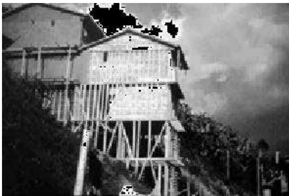
Figura 4. Viviendas a medio Balcón
