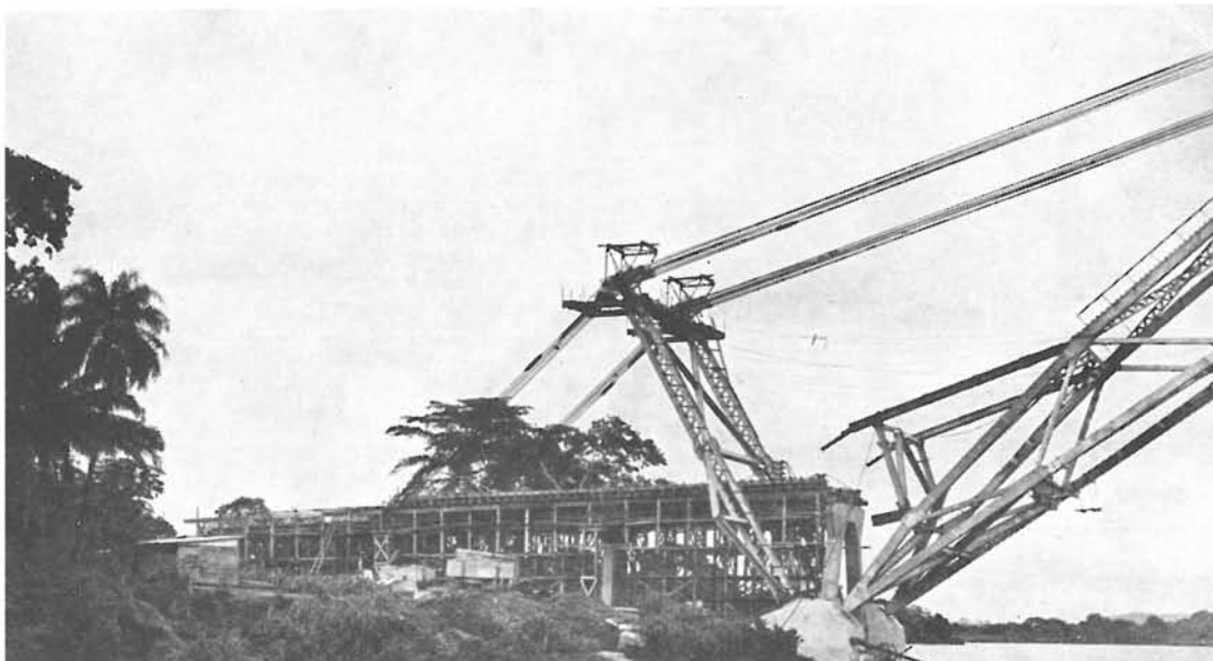
Mástil auxiliar y vientos anclados en tierra.
