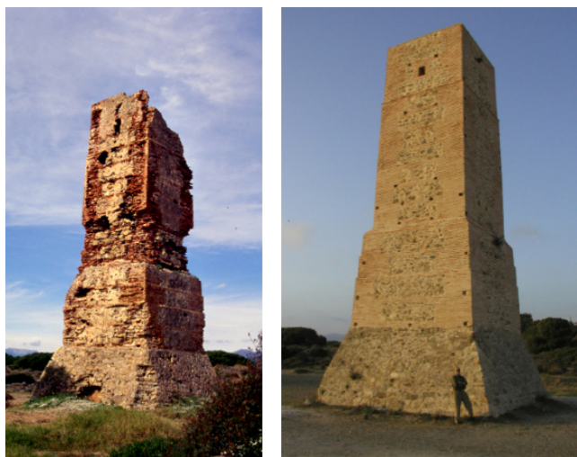
Figura 4. Torre Ladrones antes y después de su restauración por el Arq. Cesar Olano.
