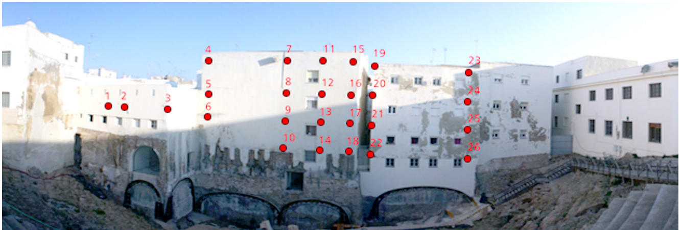
Figura 8. Situación de los miniprismas.
