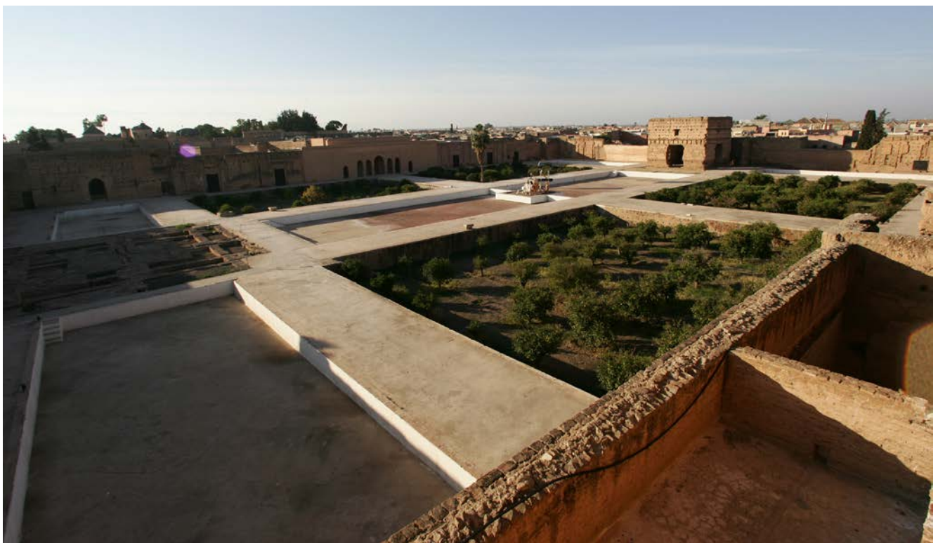
Figura 1. Vista general del palacio al-Badi' de Marrakech con el pabellón occidental al fondo.
