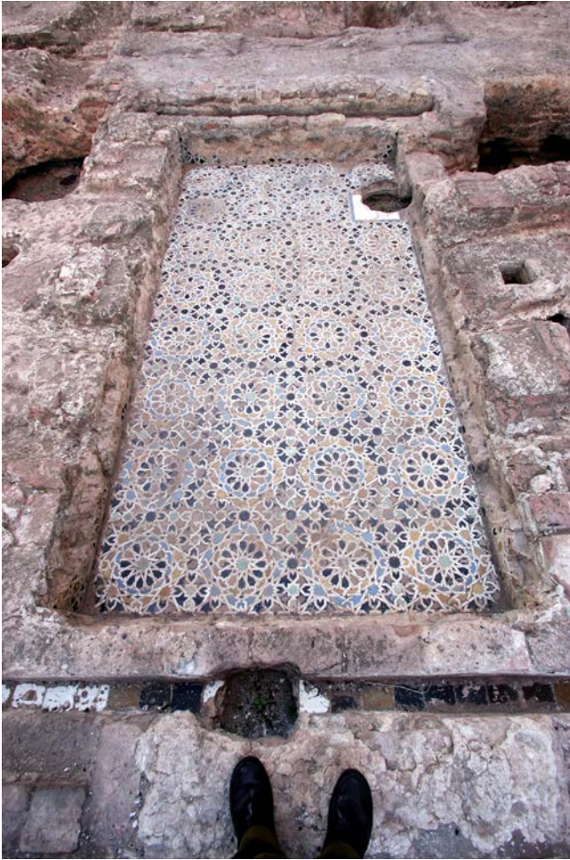
Figura 6. Vista de una de las albercas con su revestimiento de alicatado sus atarjeas de desagüe y las improntas de las tuberías de alimentación.
