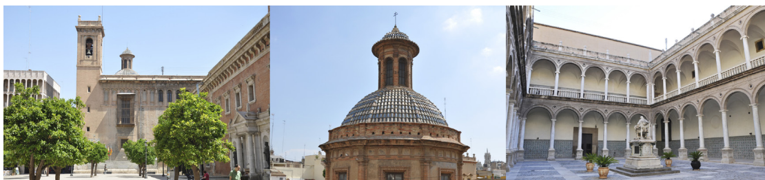
Figura 1. Vista general del Colegio de Corpus Christi.
