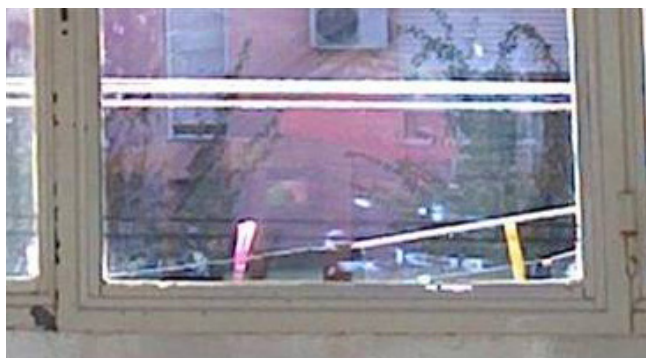
Figura 2. Ventana con perfiles de acero (C-09).
