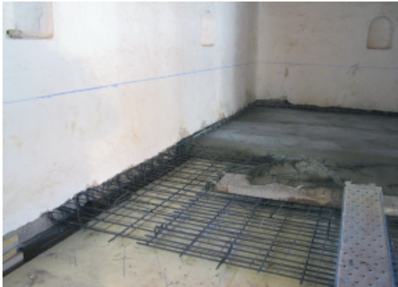
Imagen 8.- Armado de la losa de hormigón.
