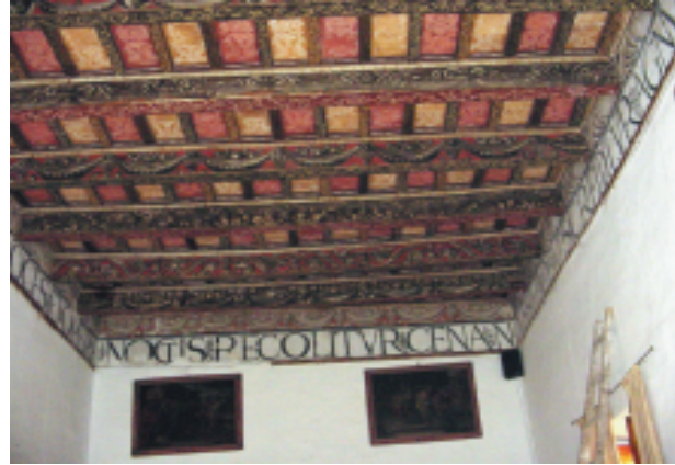
Imagen 2.- Vista general del techo del refectorio.
