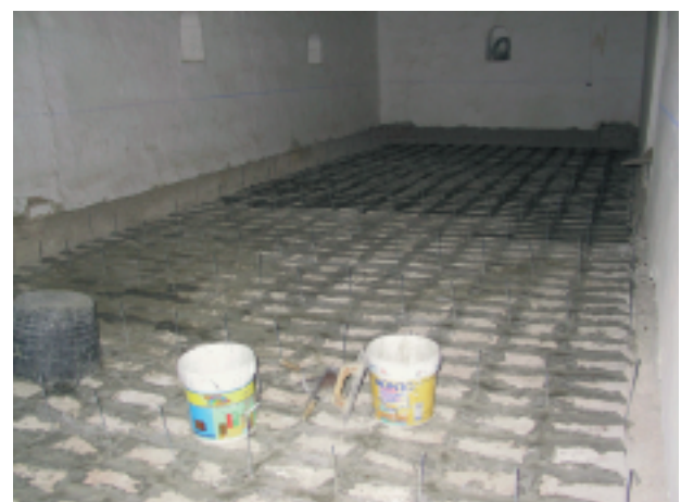
Imagen 7.- Forjado con conectores y plancha de poliestireno extrusionado.
