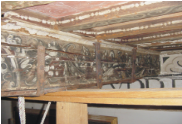
Imagen 3.- Refuerzo de las vigas mediante pletinas metálicas.
