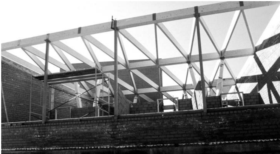
Figura 4. Cubierta en fase de montaje.
