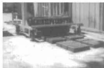
12.- La máquina colocadora va depositando, sobre la plataforma nivelada, 6 ladrillos por postura.
