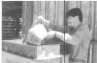
2.- Luego, se agrega cemento, según el dosificación pre-establecida.
