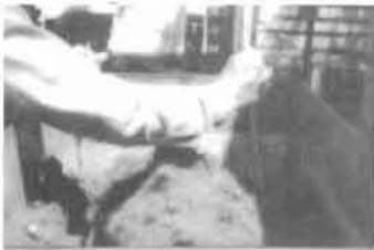
4.- Cuando esta mezcla adquiere un color uniforme, se agrega el agua.
