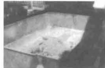
3.- Los componentes, tierra y cemento, son mezclados en seco.
