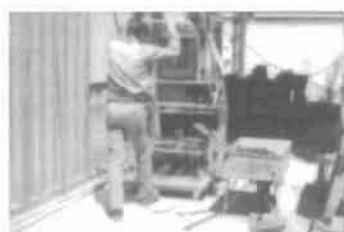
8.- Se sueltan los pisonos, que caen libremente y, por medio de una palanca, son levantados para ejercer 4 ó 5 golpes más.
