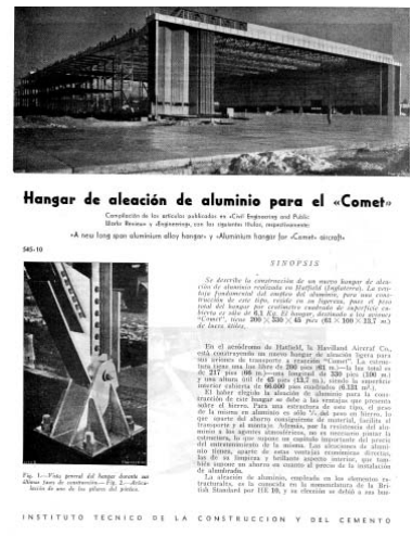
Figura 14.- Hangar de aleación de aluminio recogido en el nº 56 de 1953.
