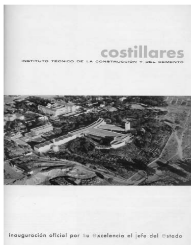
Figura 4.- Portada Informes de la Construcción, nº 99 de 1958 con motivo de la inauguración del emplazamiento definitivo del Instituto.
