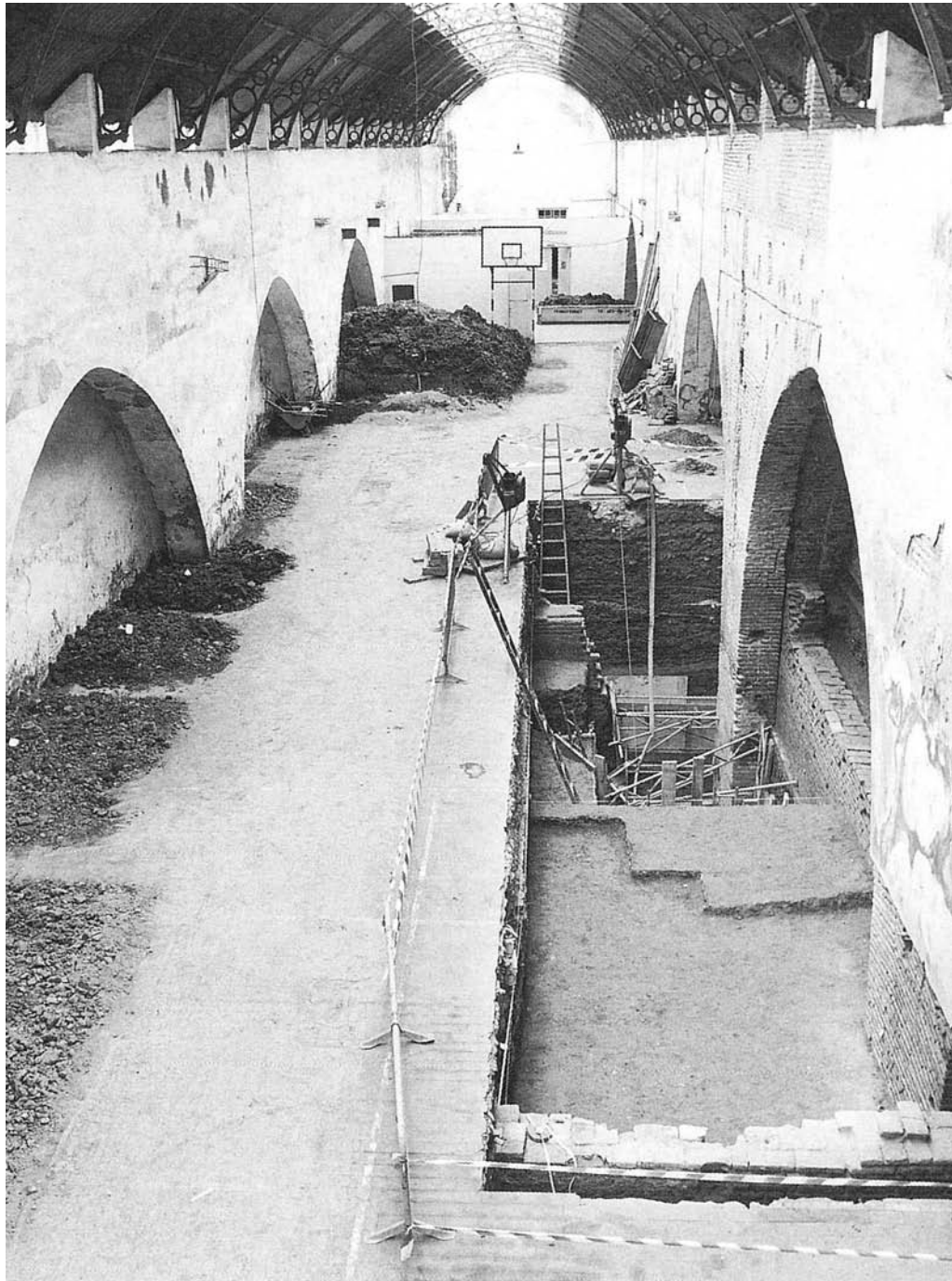
Figura 2.- Cata de pilastra.
