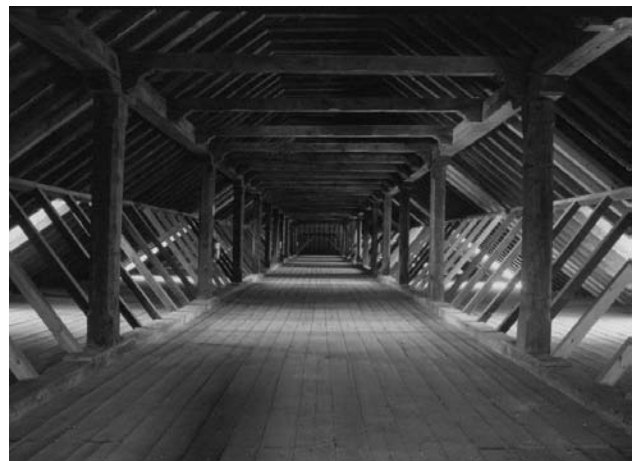
Figura 13.- Buhardilla rehabilitada Cuerpo de Cabecera.
