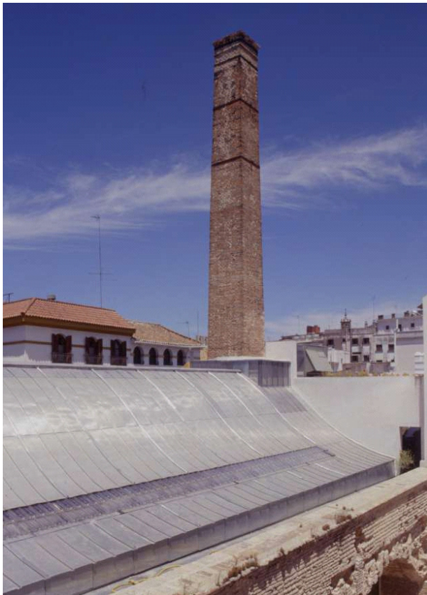
Figura 8.- Vista cubierta de la Sala Fundición Atarazanas.
