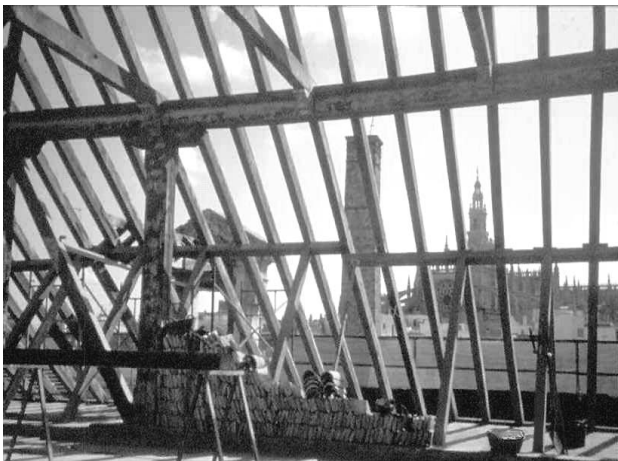
Figura 12.- Obra cubierta Cuerpo de Cabecera.
