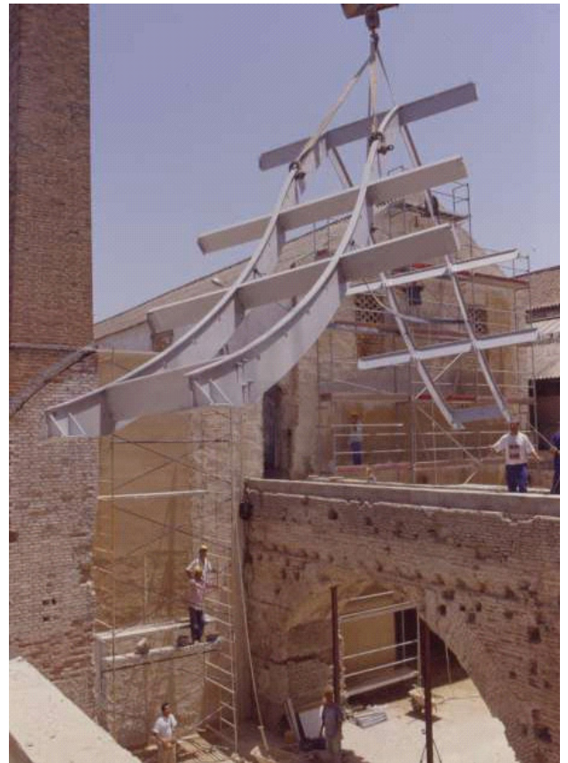
Figura 9.- Cubierta en construcción.
