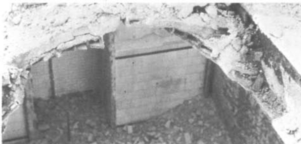
Detalles de la situación actual del soporte a restaurar.
