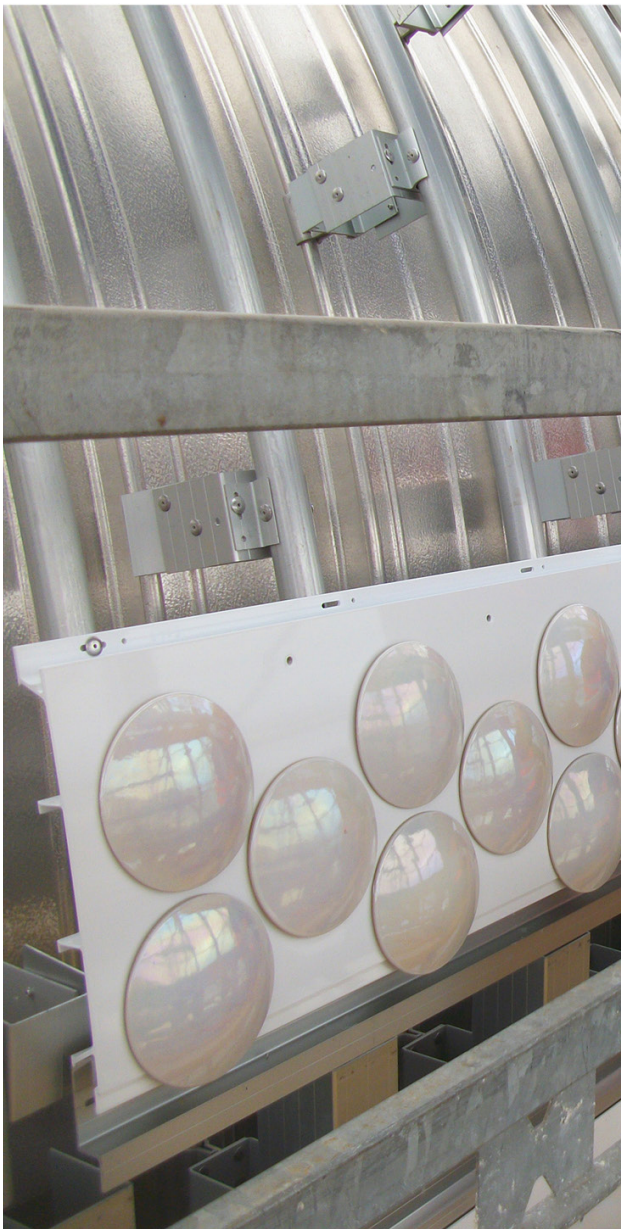
Figura 5. Bandeja de aluminio nervada sobre subestructura de nivelación y discos cerámicos roscados a ella (Archivo Disset).
