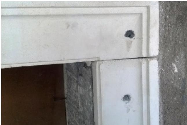
Figura 10. Ejecución de reanclado de emboadura de ventana.
