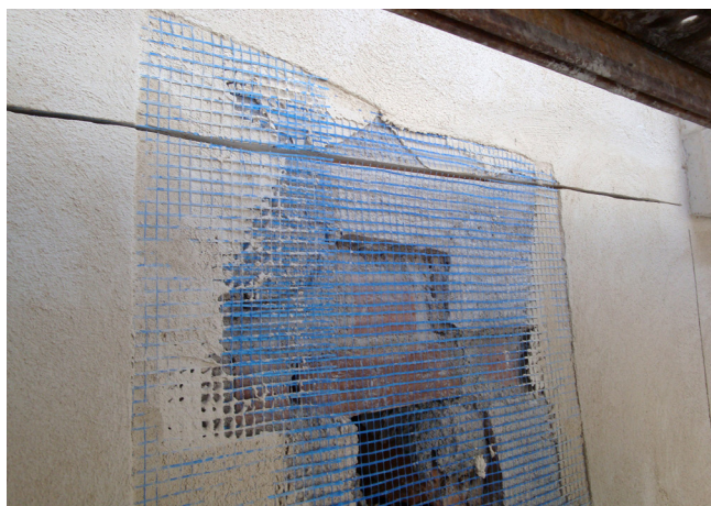
Figura 14. Malla de armado de la capa base.
