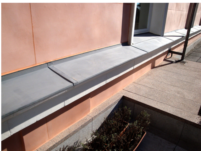
Figura 16. Cobertura de cornisa inferior con plancha de zinc engatillada.
