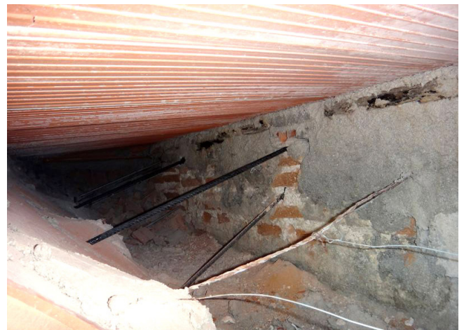
Figura 8. Varillas de reanclado atravesando la pieza hasta alcanzar el muro soporte.
