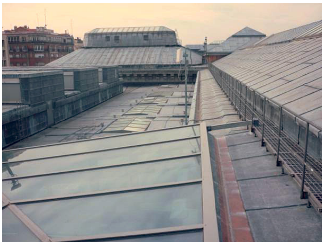
Figura 1. Vista de la actual cubierta del Museo Nacional de El Prado.
