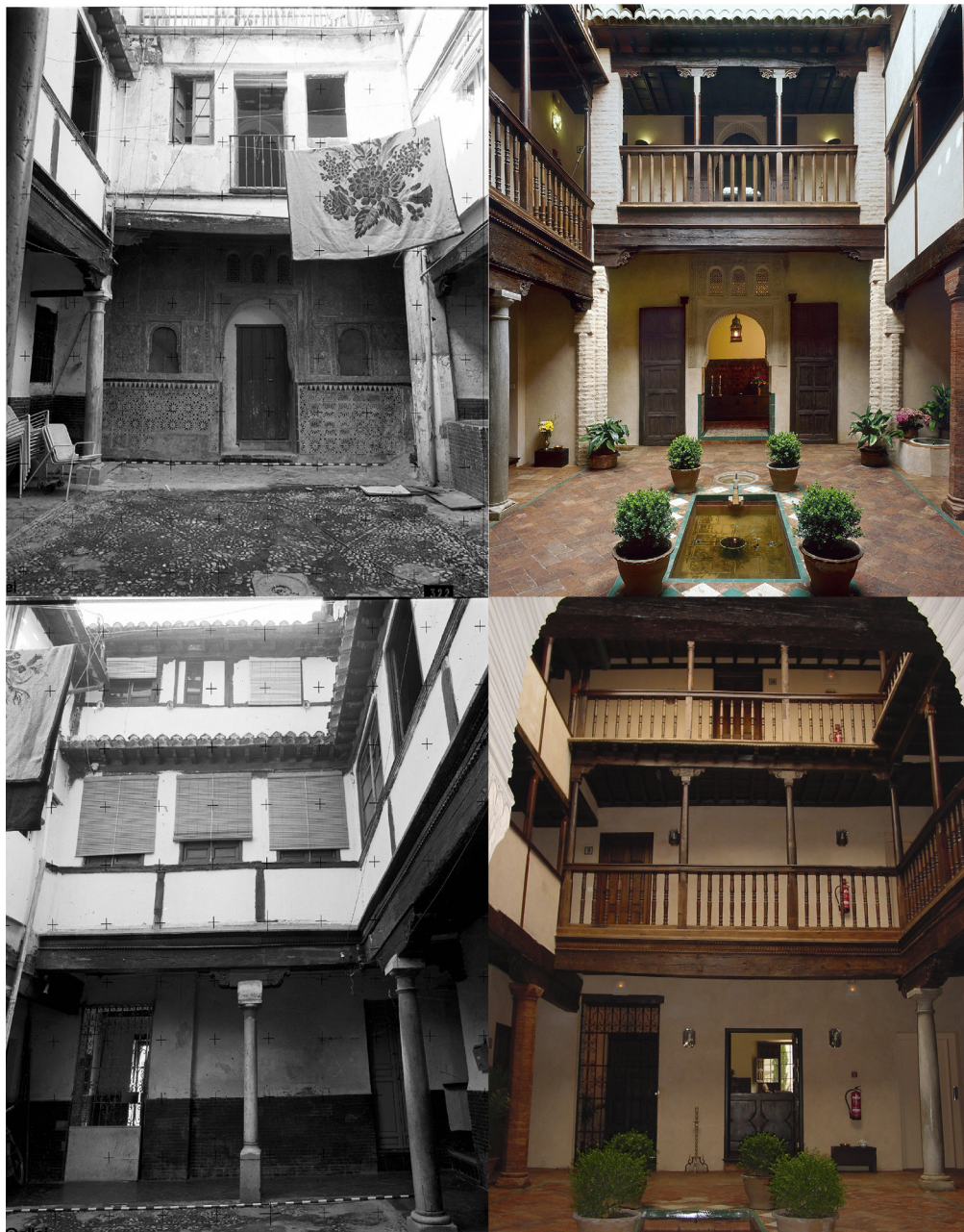
Figura 5. Alzados oeste y este del patio de Cuesta de la Victoria 9 antes y después de la intervención. Archivo Carlos Sánchez.
