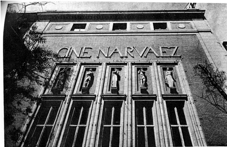
Detalle de la fachada
