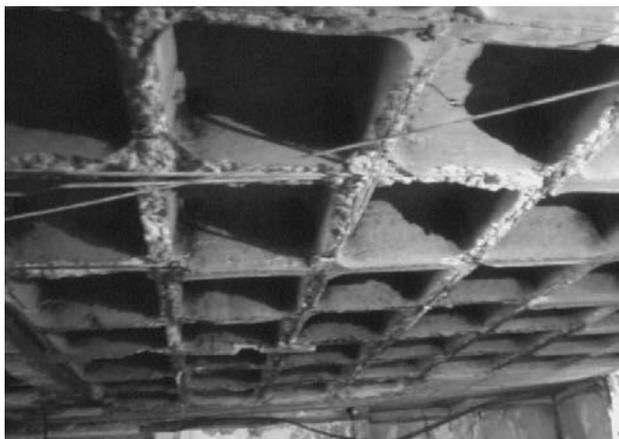
Figura 15.- Forjado de hormigón afectado por fuego.
