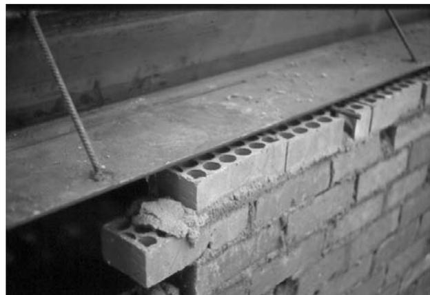
Figura 7.- Estructura auxiliar realizada «in situ» para apoyo de hoja exterior.
