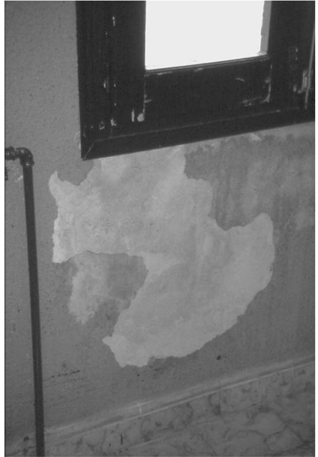
Figura 12.- Filtración por vierteaguas de ventana.
