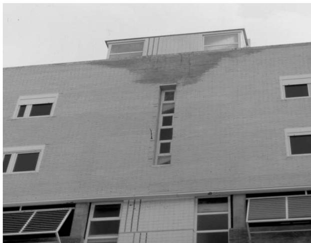
Figura 13.- Filtración en cubierta plana.
