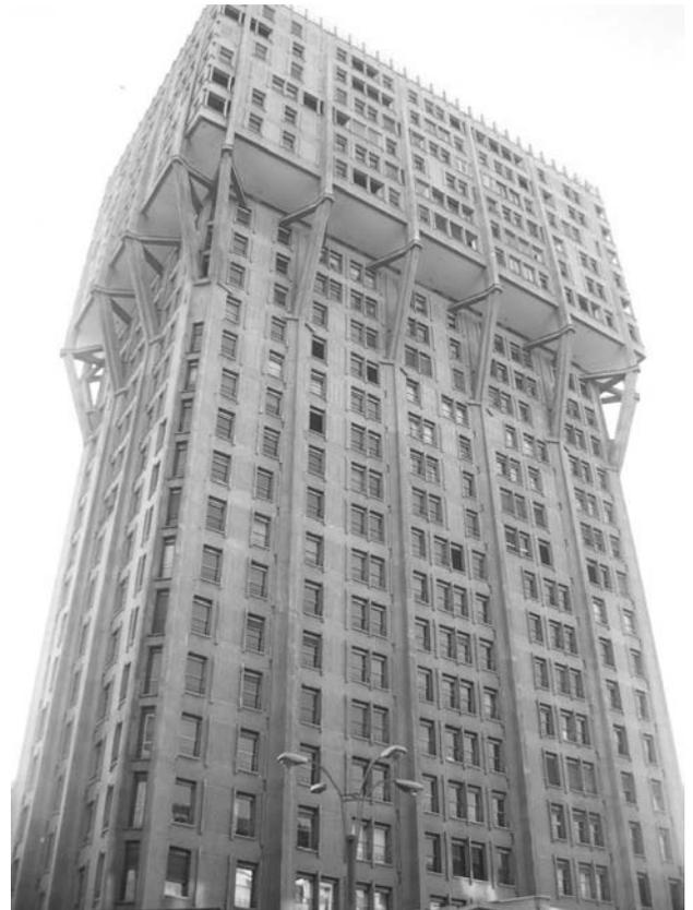
Figura 14.- Estructuras de pilares y vigas que influyen en la imagen del edificio.
