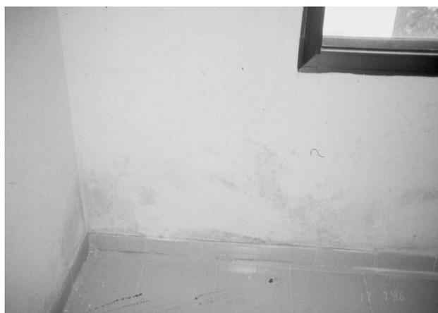
Figura 11.- Humedades de condensación superficial interior por fachada ligera sin aislamiento suficiente.
