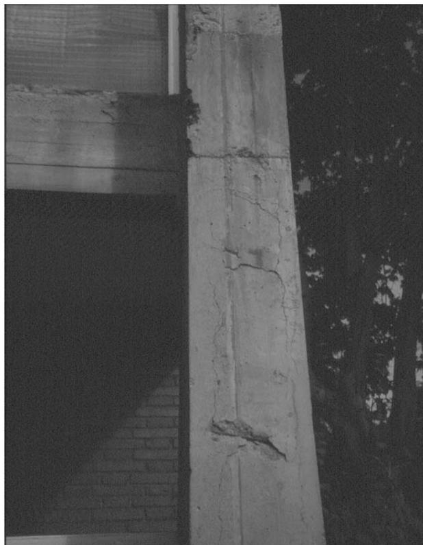
Figura 17.- Estructura de hormigón vista afectada por agentes meteorológicos.
