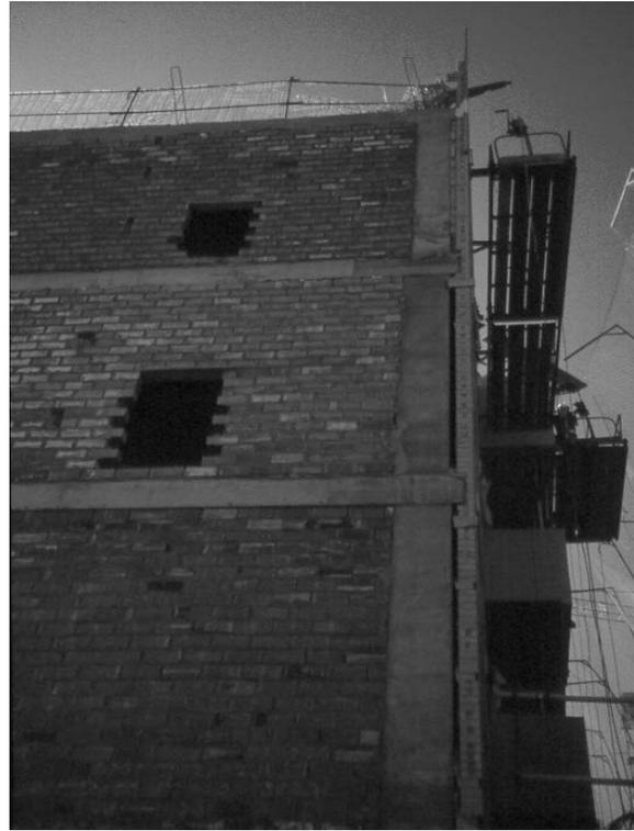
Figura 6.- Hoja de 1/2 pie de ladrillo apenas apoyada en estructura de hormigón.
