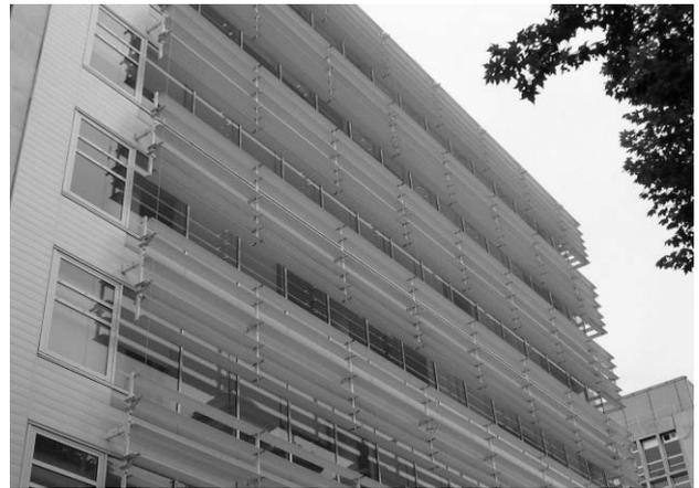
Figura 22.- Elementos de protección de fachada acoplables.
