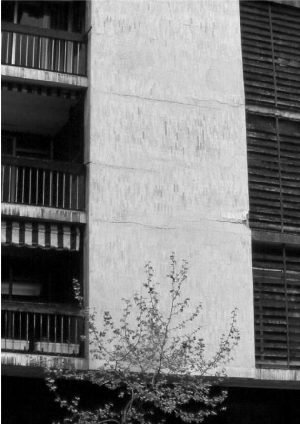
Figura 8.- Grietas producidas por flechas de vigas de borde.
