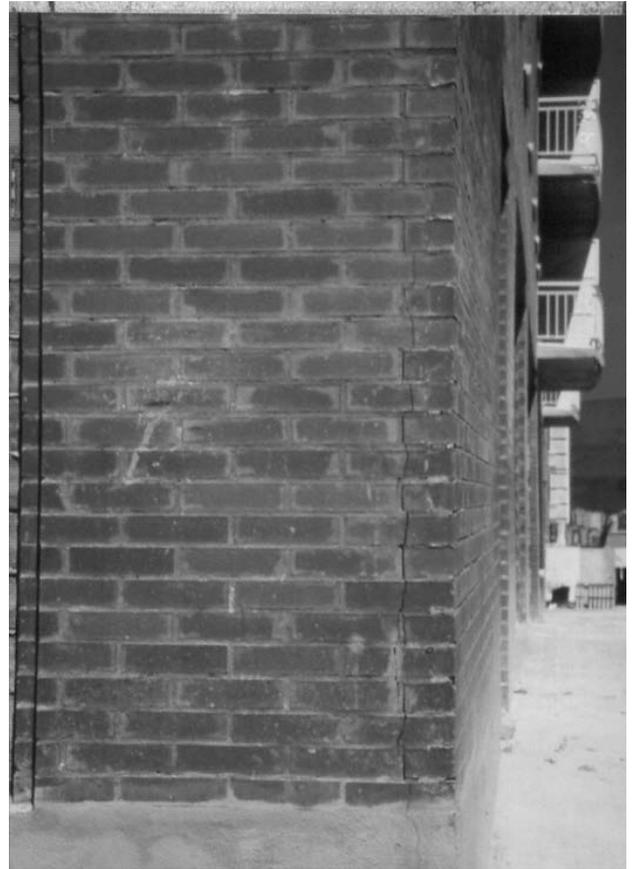
Figura 9.- Grieta en esquina producida por pandeo de pilar.
