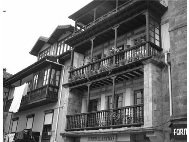
Figura 3.- Pilares y vigas de madera.
