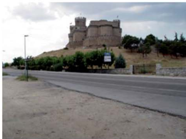
Tramo 4: Manzanares el Real
