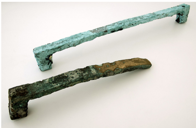
Figura 6. Vista de dos de las grapas de bronce que se extrajeron del gablete del hastial sur, encontrándose una de ellas en un estado avanzado de corrosión (2013).
