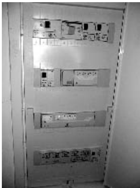
11. Cuadro general para una instalación de domótica.
