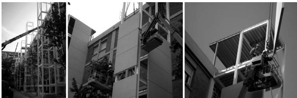
18. Imágenes tomadas durante la ejecución de la estructura y la colocación de los paneles de hormigón armado.
