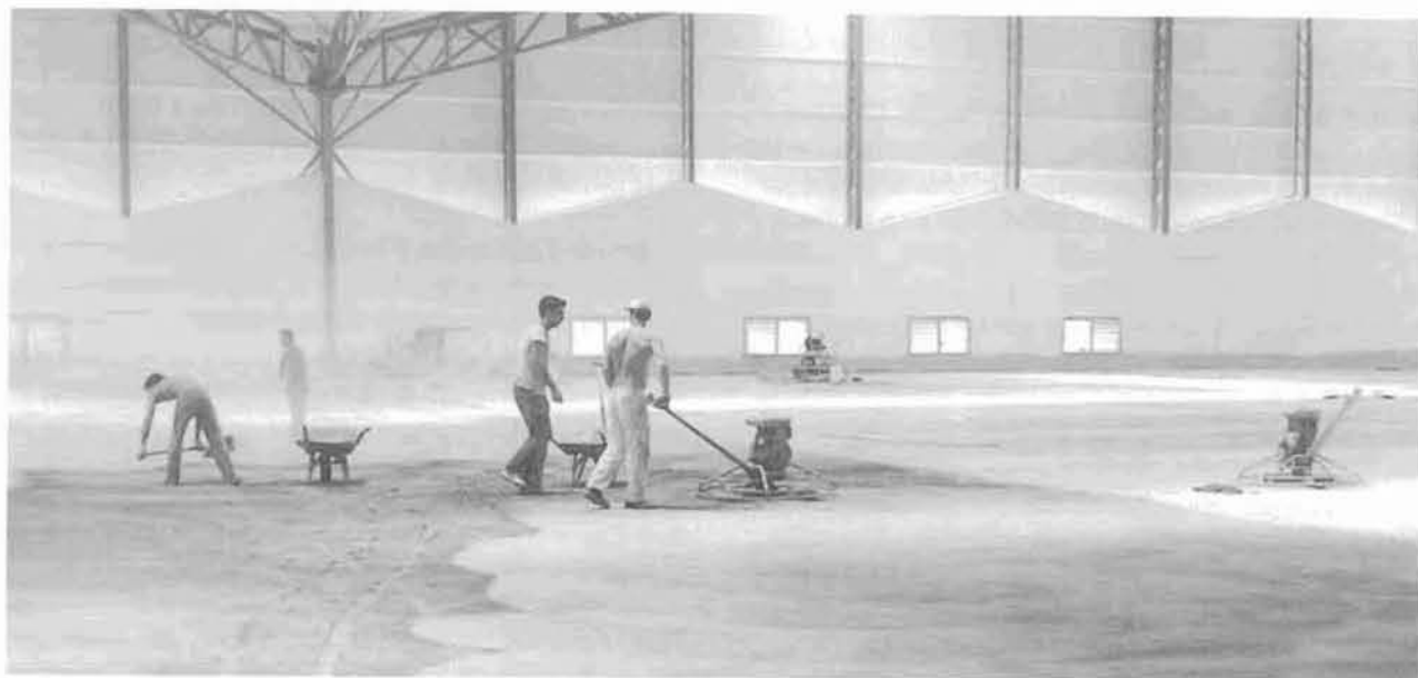
Foto 1.- El comportamiento de la solera como elemento constructivo depende, en gran medida, de la buena ejecución y puesta en obra.
