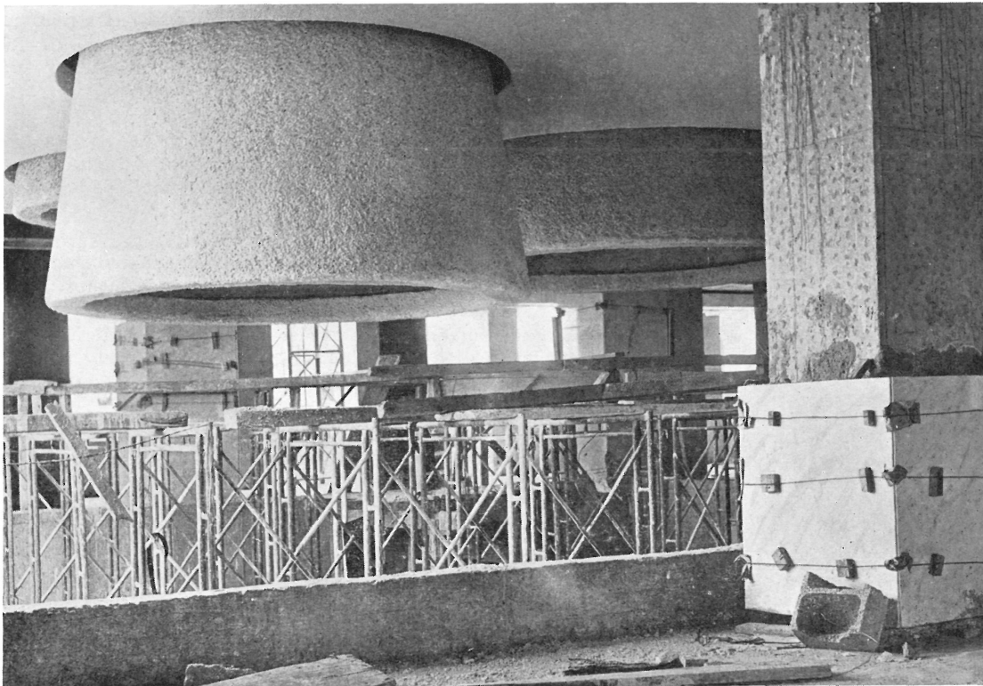
Techo entrada principal.
