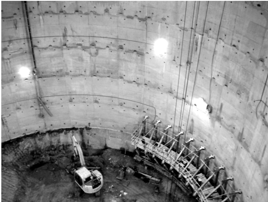
Figura 7. Medición del perfil real de la excavación con Koden.
