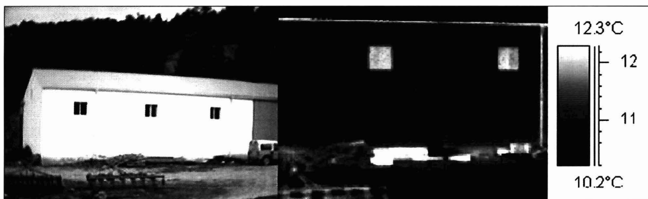
Figura 3.- Nave agrícola. La termografía revela la presencia de una junta de importante espesor en el muro. Tomada al amanecer.
