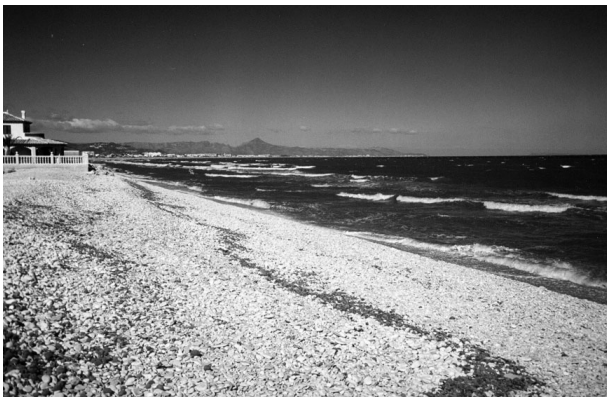
Figura 2A y 2B.- Aspecto general de la degradación por erosión de la playa.
