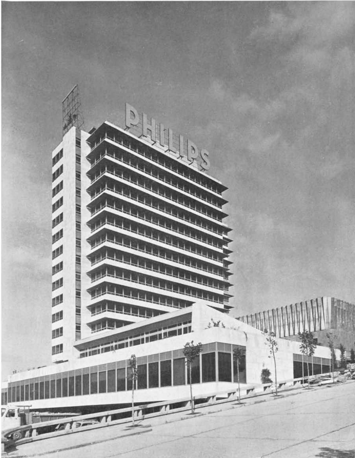
Fachada, a mediodía, protegida por voladizos. En primer término, los volúmenes de cantina y salón de actos.
