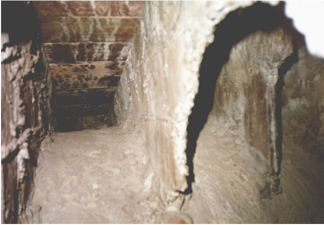
Figura 5. Hoja interior trasdosada por tabiquillos. Iglesia de San Roque, Oliva, Valencia.
