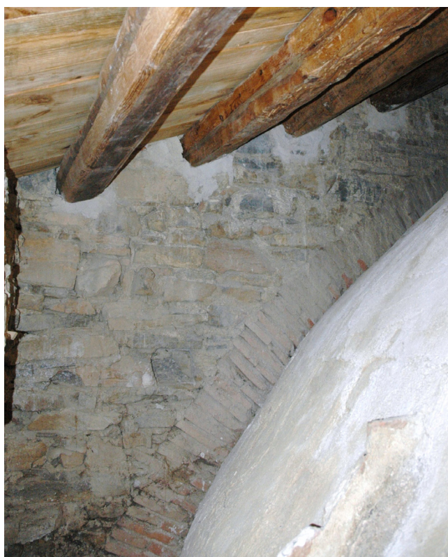
Figura 4. Cúpula capilla trasdosada por entramado de madera. Olocau del Rey, Castellón.
