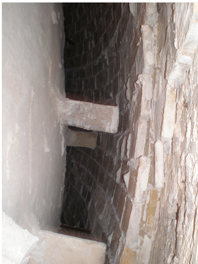
Figura 7. Iglesia Asunción. Carcaixent. Hoja exterior tabicada. Espesor 6cm, diámetro 12 m.
