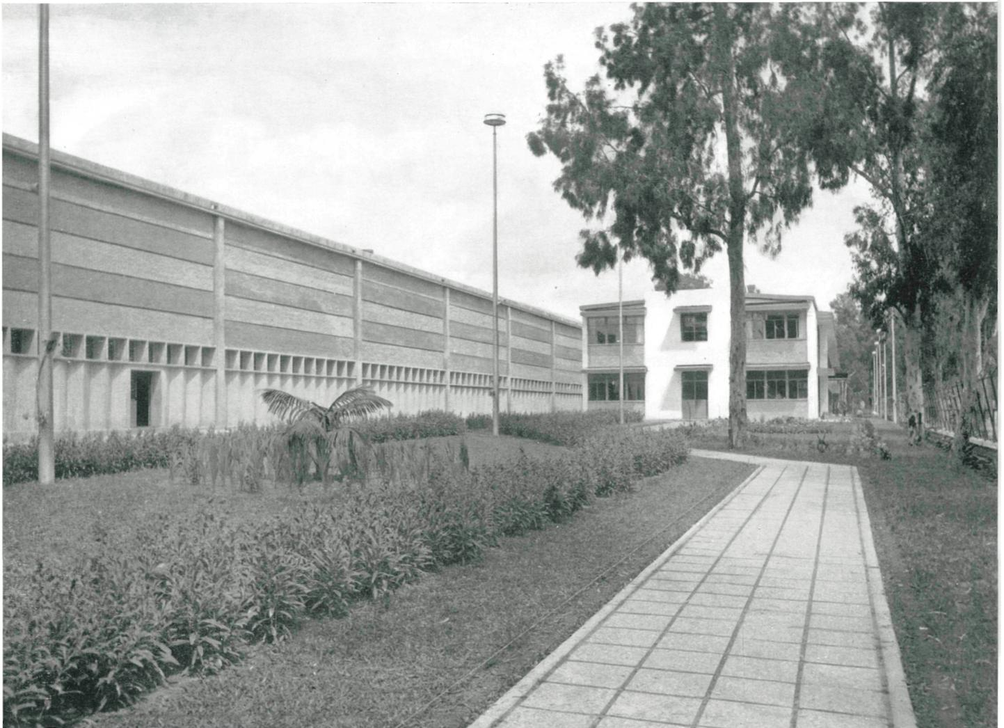
Las fachadas N. y S. van enfoscadas y pintadas con Lesar, hasta el enrase con los muros de hormigón laterales, con un entrante de 10 centímetros; el cuerpo alto está tratado con los mismos materiales y acabados que las fachadas E. y O.
