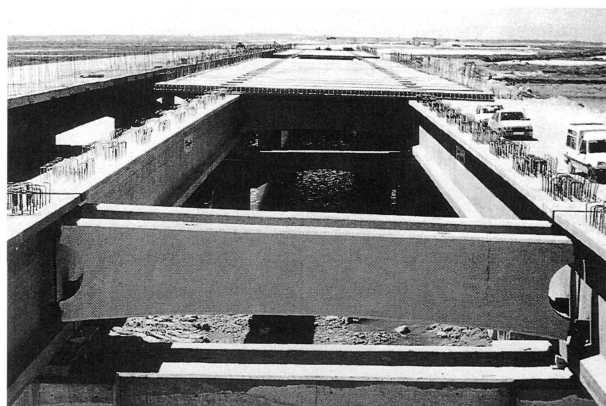
Fig. 7.- Fotografía del puente en fase de montaje de piezas prefabricadas.
