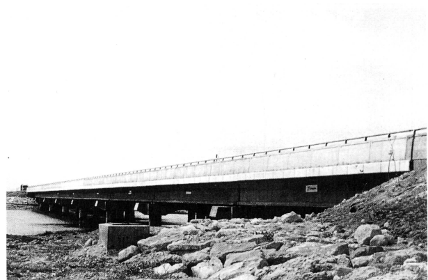
Fig. 12.- Fotografía del puente completamente terminado.
