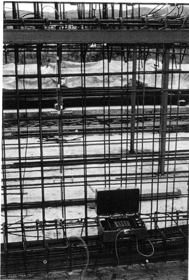
Fig. 10.- Fotografías de la instrumentación de una viga y de los sensores en detalle.
