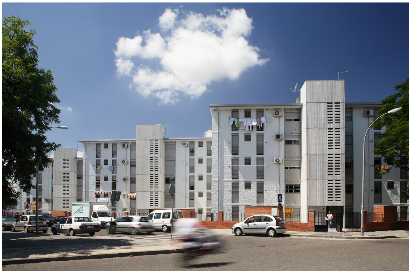
Figura 7. Edificios rehabilitados en San Martín de Porres. Fotografía Manu Trillo. 2007.
