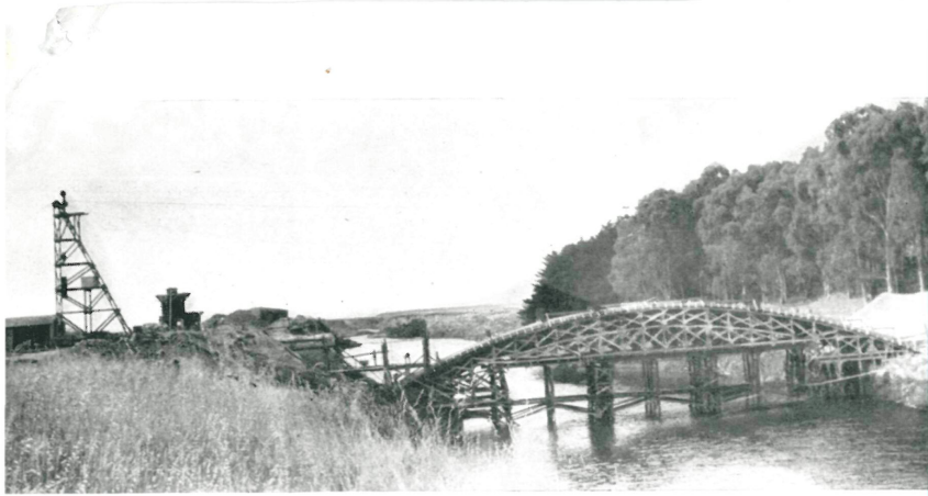
Vista de la cimbra del arco.
