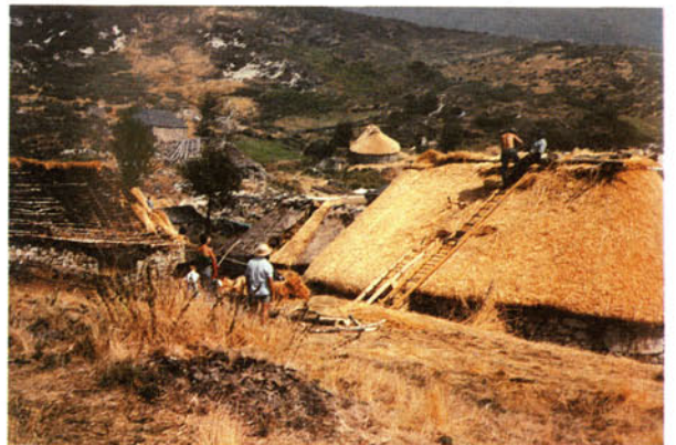
Encumiando. El techo está terminado.
