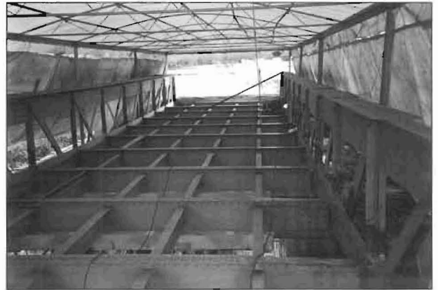
Foto 3.- Proceso de reparación. Vista general.
