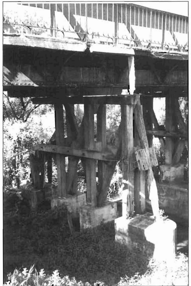
Foto 4.- Estado inicial. Apuntalamiento.
