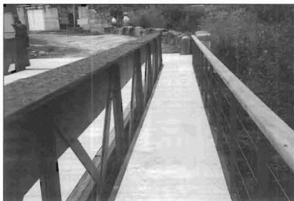
Foto 10.- Estado definitivo. Detalle.
