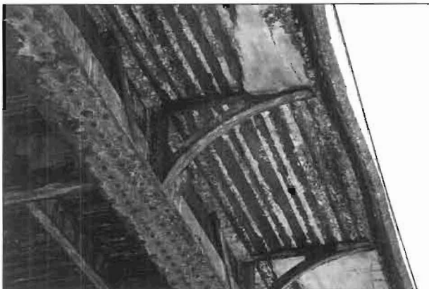
Foto 2.- Estado inicial. Vista inferior del Tablero.
