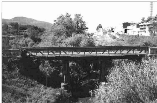
Foto 1.- Estado inicial. Vista general.
