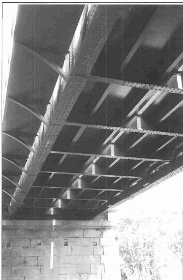
Foto 9.- Estado definitivo. Vista inferior del Tablero.
