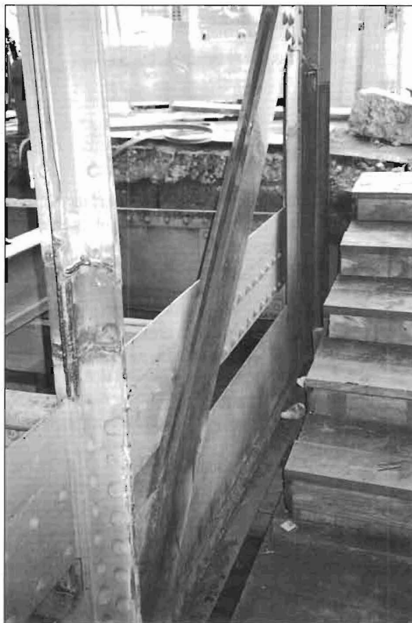
Foto 5.- Proceso de reparación. Regeneración.
