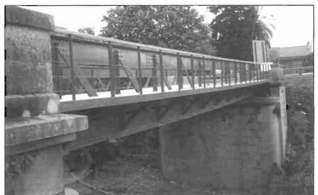
Foto 8.- Estado definitivo. Vista general.
