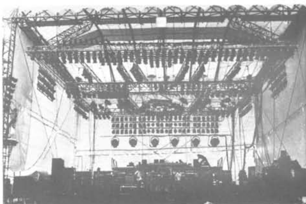
Foto 19. – La instalación luminica en sus «barras» es elevada hasta la rejilla mediante cadenas.
