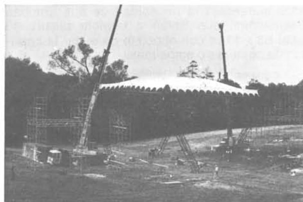
Fig. 18. - Mientras «la rejilla» cuelga, son colocadas las patas en su lugar mediante ruedas.
