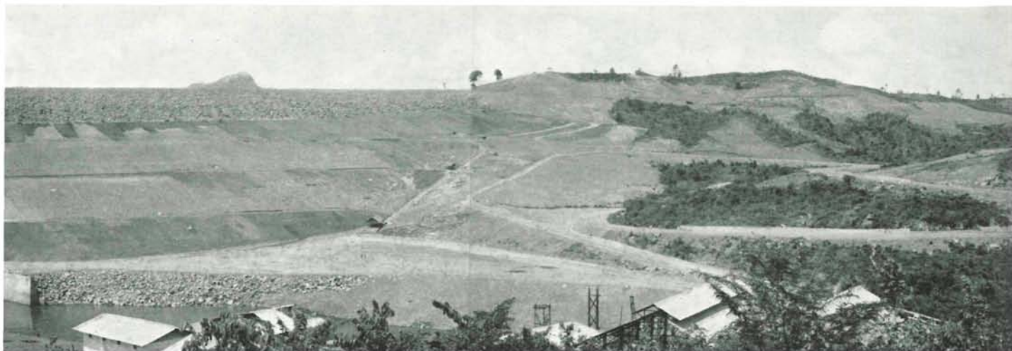
La presa desde aguas abajo.
