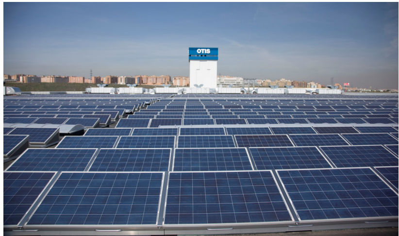
Figura 2. Fábrica sostenible de Otis en Leganes. Cubierta con huerto Solar.
