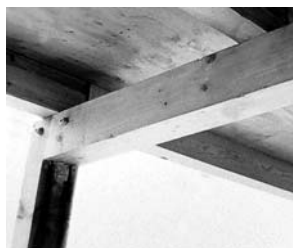
Figura 6. Unión articulada de la viga de cubierta.
