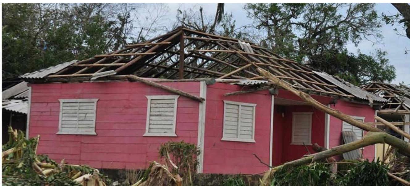
Figura 1. Impacto de los huracanes sobre las cubiertas ligeras de fibrocemento en las provincias del oriente cubano.
